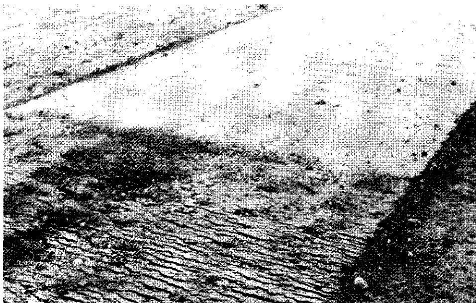
Fig. 111. Met een aangedreven rol treden bij het aandrukken geen scheurtjes op; bij een niet aangedreven rol wel (foto Andringa).
