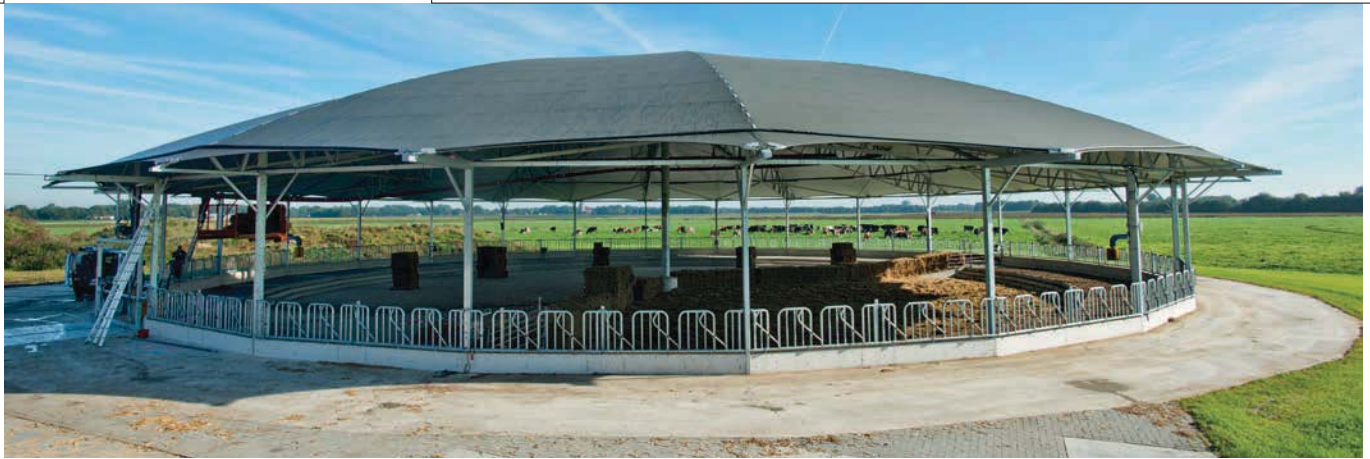
De koepelstal met een diameter van 45 meter heeft een vloeroppervlak van 1600 vierkante meter
