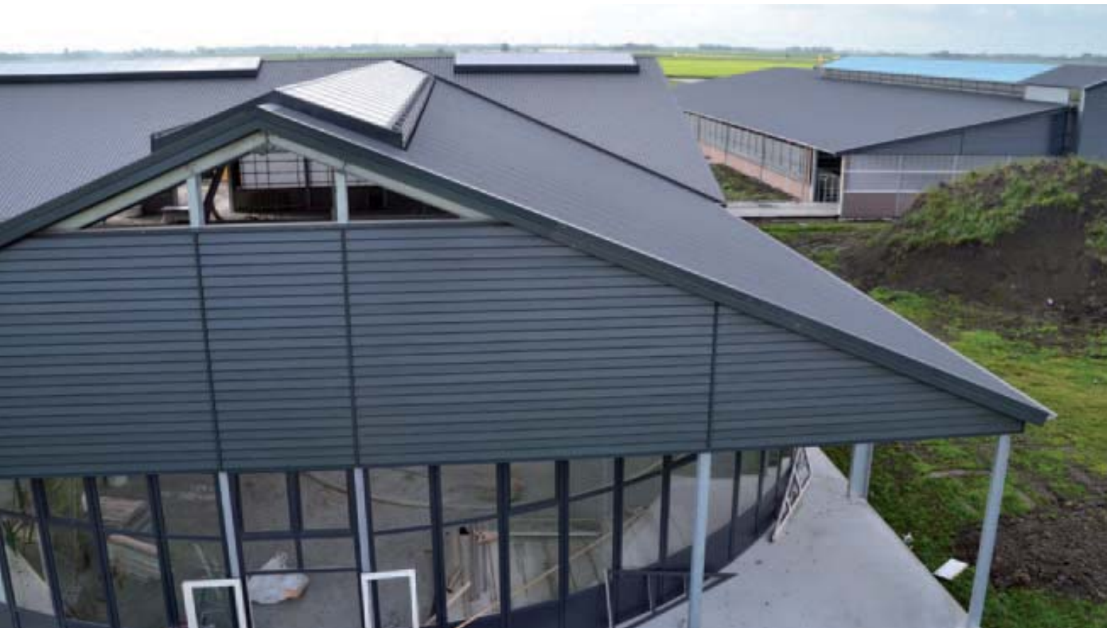
De stallen van Dairy Campus in aanbouw met geïsoleerde sandwichpanelen als dakbedekking. De stal rechts is uitgevoerd met een opgezette systeemnok.
