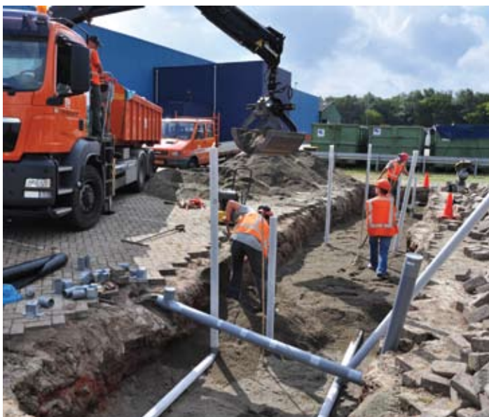
Aanleg van drie pilot-boomgroeiplaatsen op de parkeerplaats van Van Gansewinkel in Rucphen.
