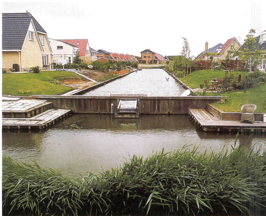
Vanwege onmin over het hoge waterpeil is een eerder aangelegde beschoeiing in de bouwfase van dit nieuwbouwplan Witzens in Franeker aangevuld met beschoeiing die op een lager peil is afgestemd.
