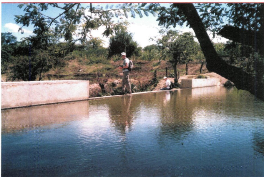
Een reeds voltooide dam in Kenia.
