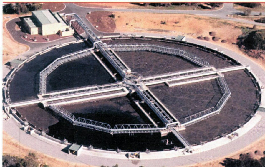
De SBR van de rwzi Woodman in Australië.
