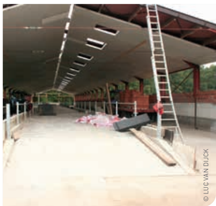
De stal werd verhoogd voor een betere ventilatie. Er kwam een nieuwe vloer en in het midden werd een verhoging aangebracht voor de voeder gang. Volgende week komen de geiten er in.
