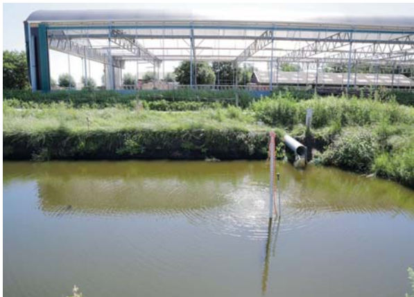
Naast de stal is een bassin waarin het regenwater van het staldak wordt opgevangen. Dat wordt gebruikt als drinkwater voor de koeien en als sproeiwater voor de mestrobot.
