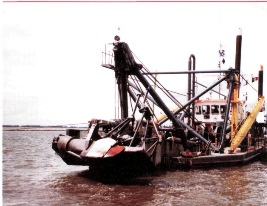
Nauwkeurig baggeren bij de sanering van het Ketelmeer.
