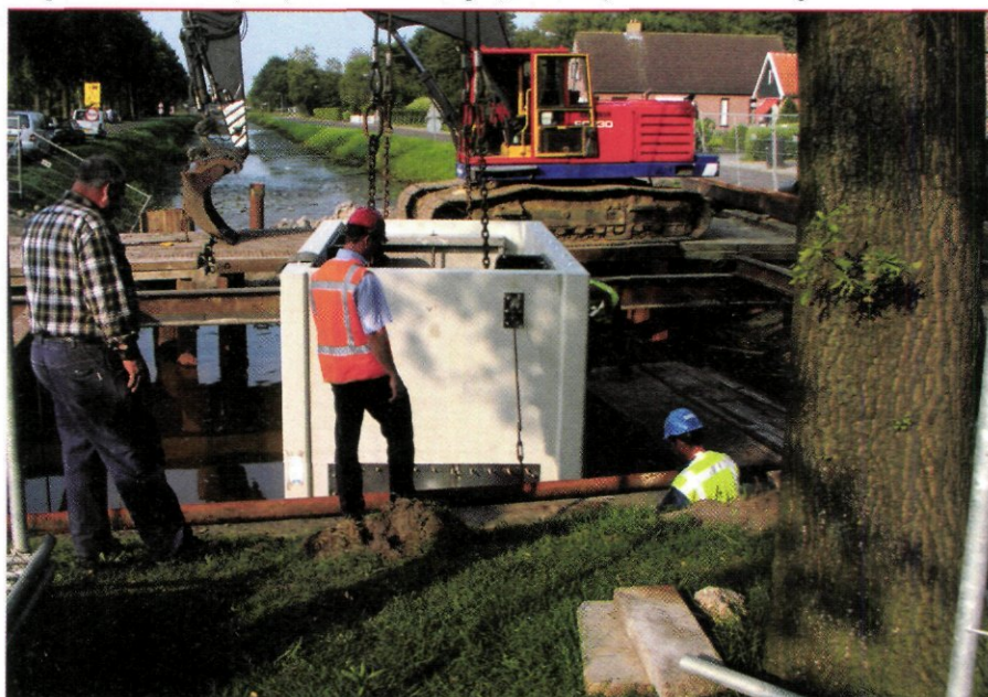
Het plaatsen van de eerste (onder) en tweede betonnen put (rechtsboven). Rechtsonder de huidige situatie.
