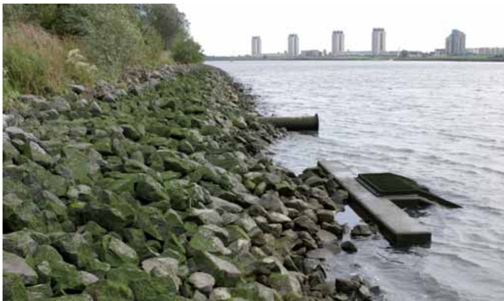
Betonnen overlaat halverwege het Visserijgriend
