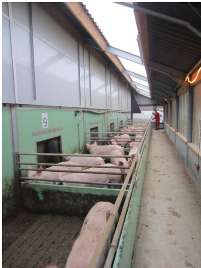
Overkapt uitloop van de Star+ stal met links de doorzichtige luchtinlaatklep naar de stal.
