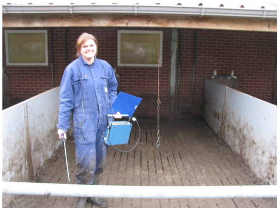
Overzicht van de afdeling buiten met een volledig betonnen roostervloer.
