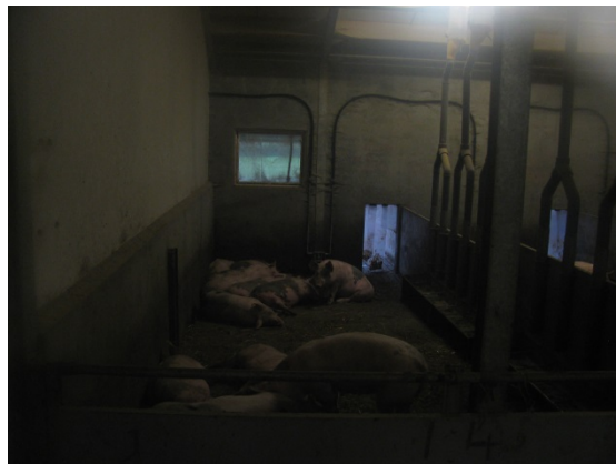
Luchtinlaat via ramen en uitloopopening; uitlaat via koker in dak
