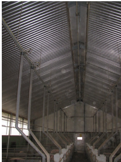
De Star+ stal wordt natuurlijk geventileerd met luchtinlaat aan de zijkanten (doorzichtige kleppen) en luchtuitlaat in de nok.
