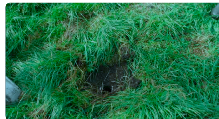
Figuur L4.3. Lokale drainage: Verticale pijp aangesloten op drainagebuis om natte plek centraal in het perceel droog te leggen. De drainagebuis verbindt een lage plek met een sloot (Bron: Massop en Noij, 2012).
