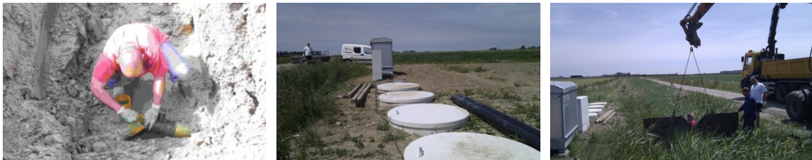
Verbinden drain met collector.
