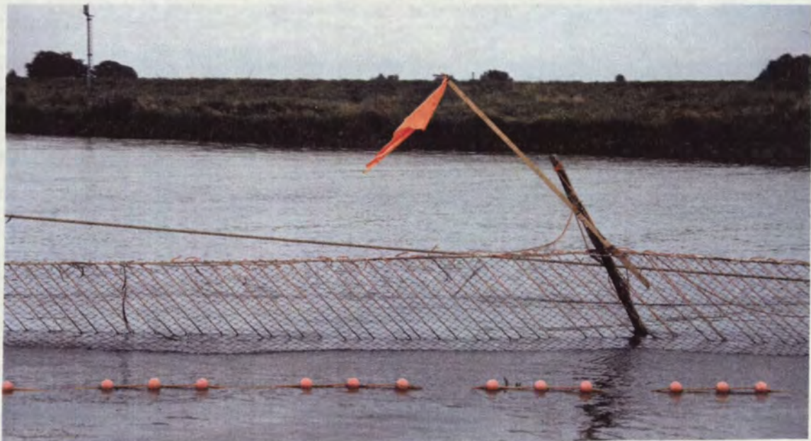
Figuur 4. Schematische tekeningen en een foto van het visgeleidend scherm.
