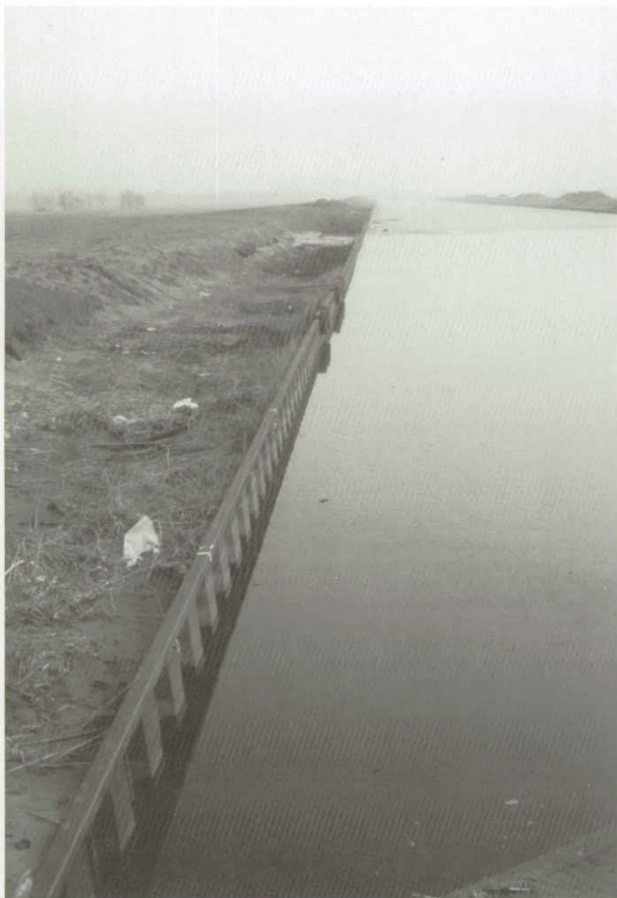
Otteronvriendelijke oever: steile damwand en geen dekking
