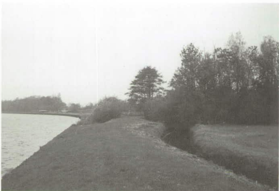
Damwandverlaging (vorige foto) met goede aansluiting op vegetatie in achterland
