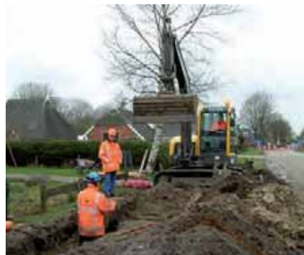
Aanleg van riolering in het buitengebied van het Friese Opsterland
