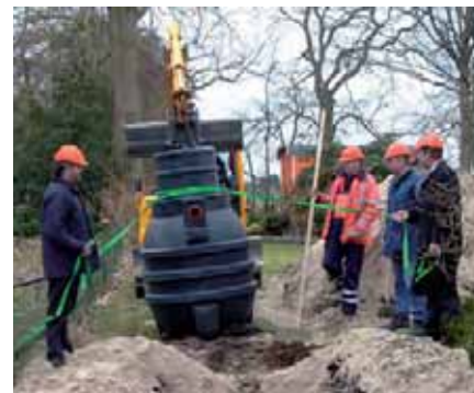
Plaatsing van IBA's klasse II
