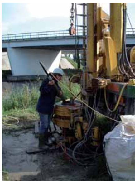
Een geo-elektrische boorgatmeting in het veld.
