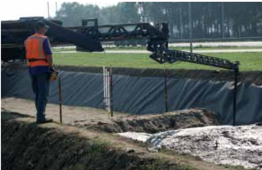
De afbraak van verontreinigingen in de baggerspeciematras langs de A2 verloopt langzamer dan verwacht.
