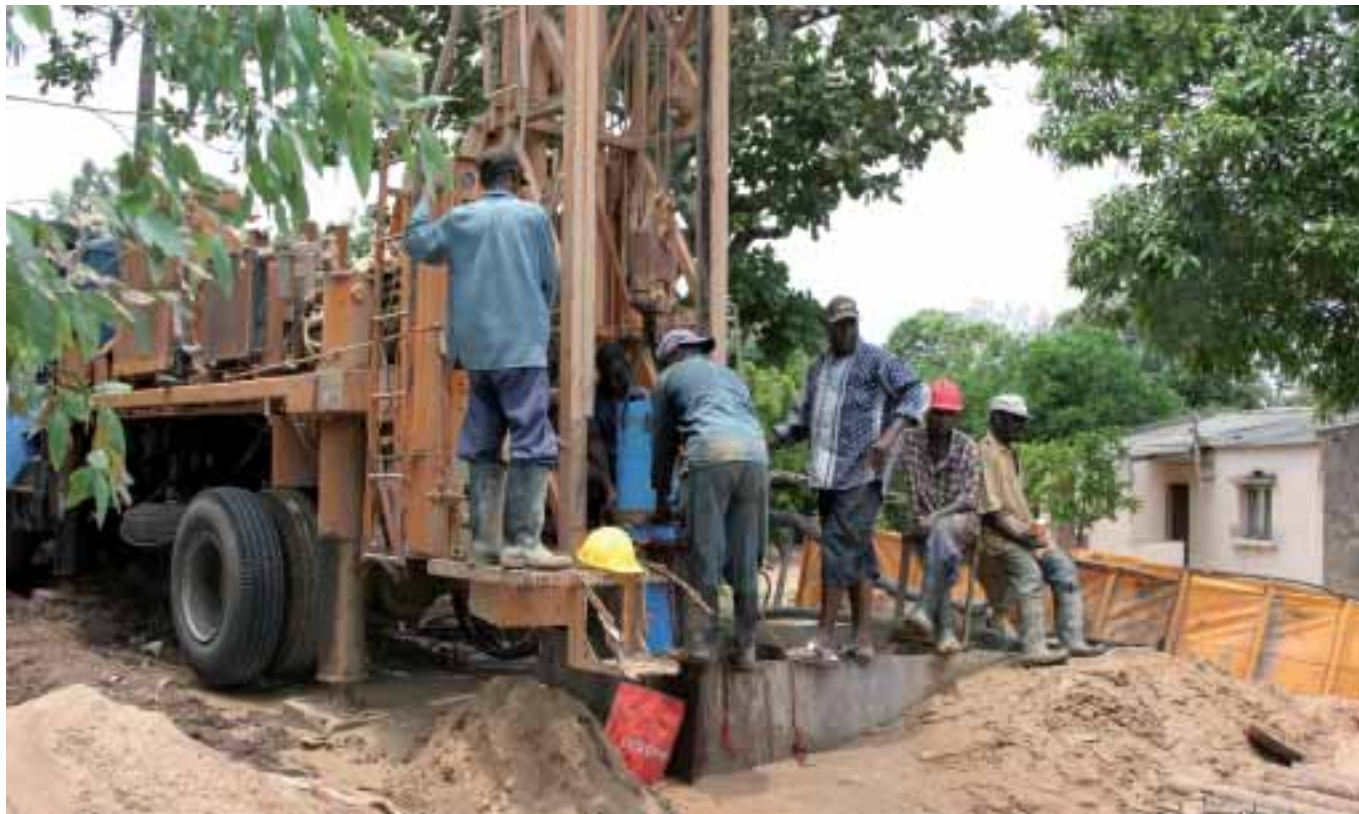
In Zuid-Mozambique werkt Vitens Evides Internationaal sinds 2004 aan het opzetten van lokale, autonome waterbedrijven op basis van een publiek-privaat partnerschap met het ministerie van Ontwikkelingssamenwerking en FIPAG. Hier wordt een nieuwe boorput aangelegd.
