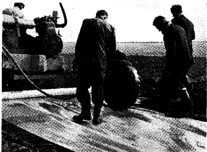
Nauwkeurig wordt gecontroleerd of de kúverbinding waterdicht is.
