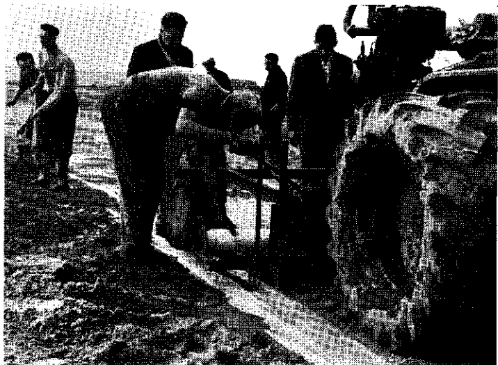
Het lijmen van de banen met een speciale kit.
