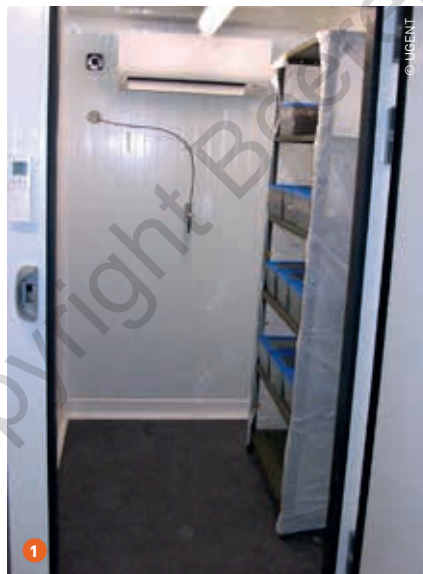
1 In de individuele kweekkamer staat een rek met bakjes. Om de juiste groeiomstandigheden te creëren is er een klimatisatiesysteem, een ventilator en sensor om de temperatuur en de relatieve vochtigheid te meten. 2 Opstelling van de bakjes met mest en larven van de zwarte soldatenvlieg.
