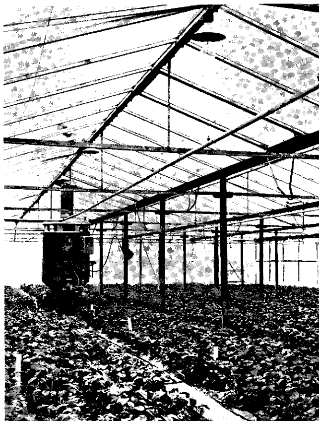
Afb. 6. Verwarming met een warme-luchtkachel in een kas met verlichting.
