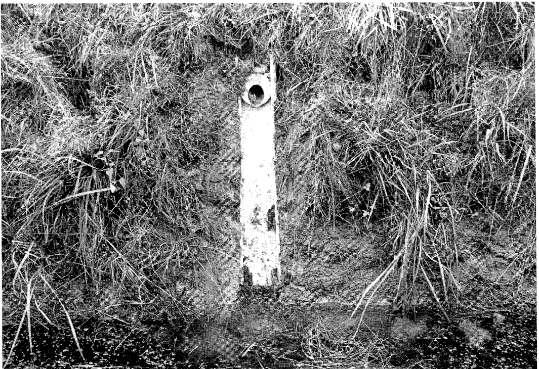
Verlaging van de grondwaterstand door middel van slootpeilverlaging kan aanmerkelijk verbeteringen geven.
