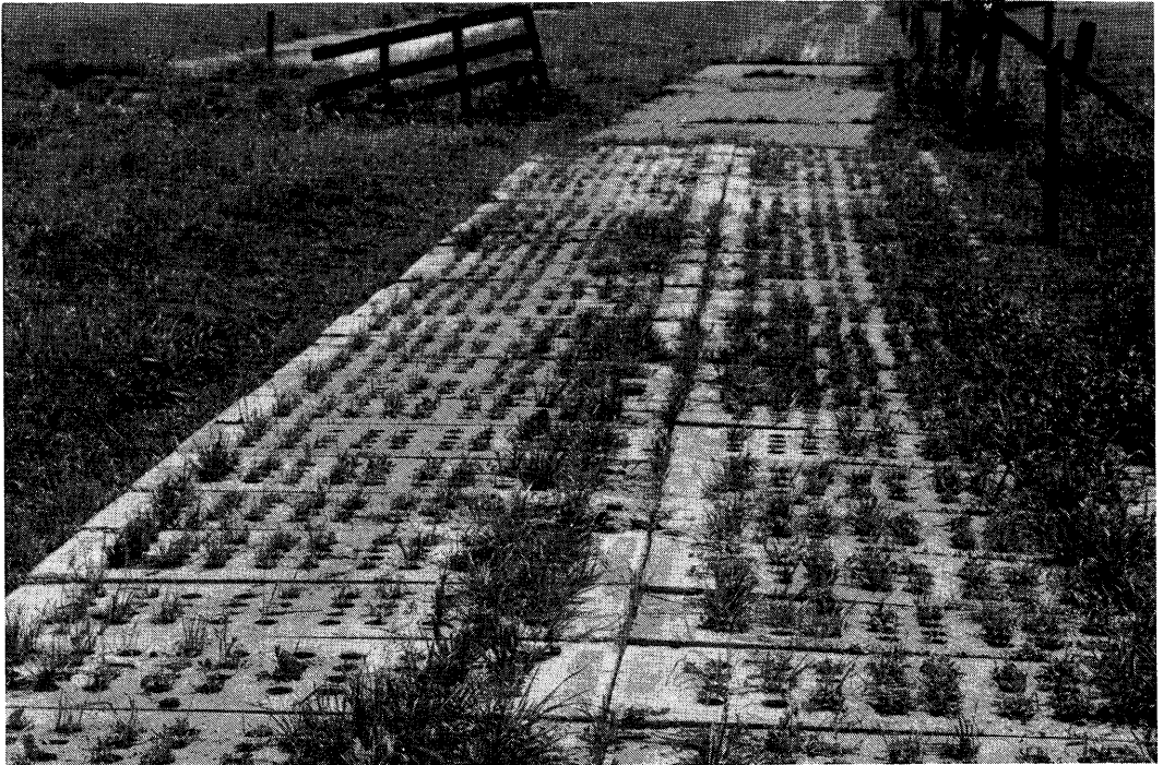
Kavelpad met groenspoorplaten als verharding. Het gras dat door de gaten groeit voorkomt in belangrijke mate het verschuiven van de platen.
