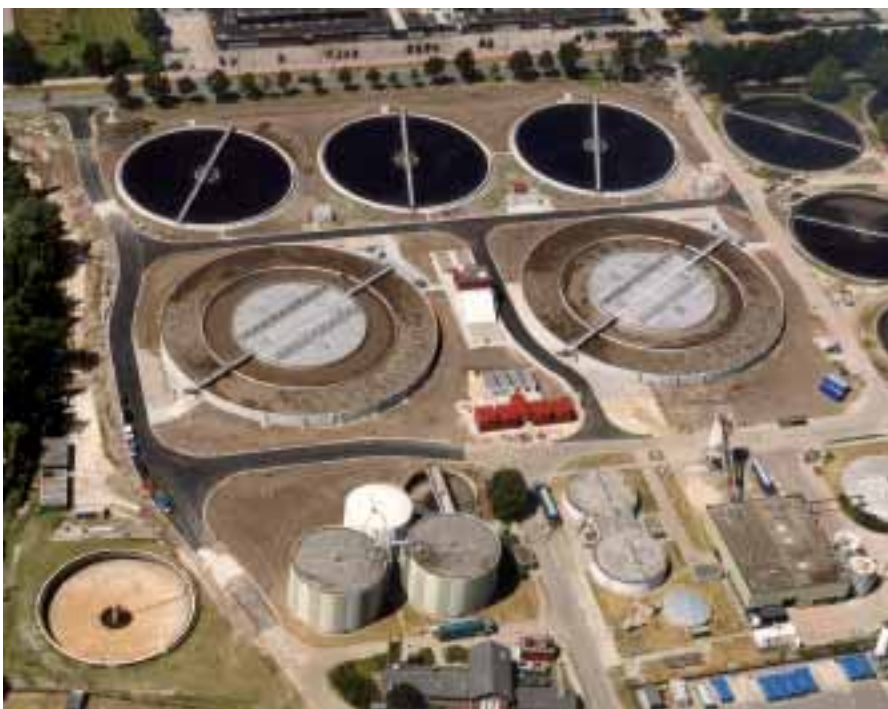
De rioolwaterzuiveringsinstallatie van Apeldoorn met enkele ronde actief-slibtanks.
