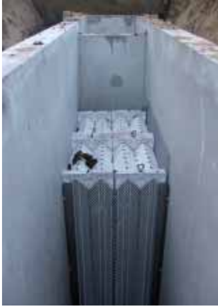
Lamellenfilter bezien van influentzijde.
