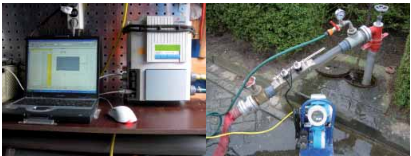
Aangepaste meetapparatuur voor het doen van OPM-analyses. Links de troebelheidsmeter en de computer om de meetgegevens op te slaan en te analyseren. Rechts de aangepaste standpijp waarmee de volumestroom gemeten kan worden en bovendien een visuele beoordeling van het water kan plaatsvinden.
