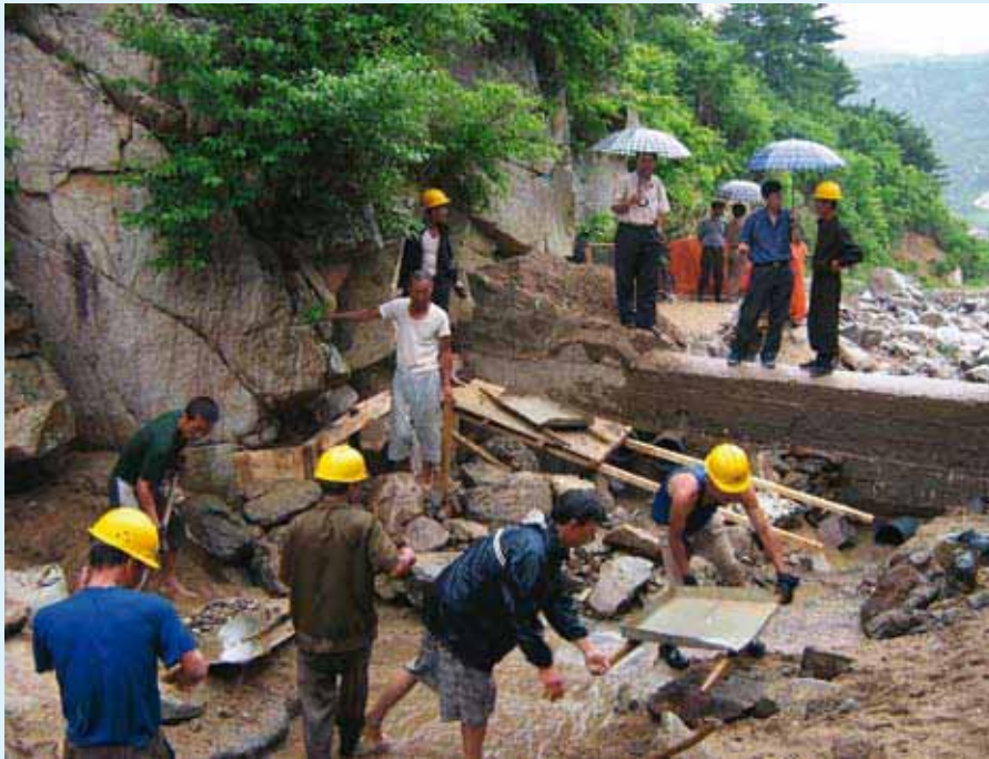
De werkzaamheden tijdens de constructie van het grof grint-zandfilter: de twee pvc-inlaatbuizen (links) en de drainagebuis (rechts) in de betonnen dam.
