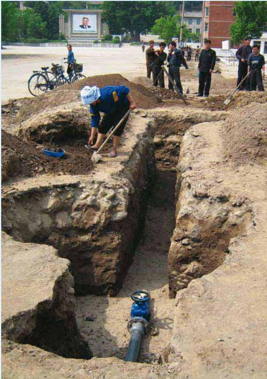
Het graven van de gleuven voor de pvc-buizen.
