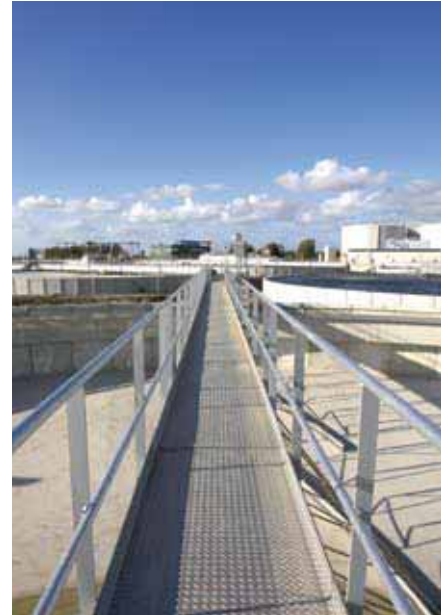
De afvalwaterzuiveringsinstallatie Harnaschpolder vlak voor de officieuze ingebruikname vorig jaar september (foto: Martin Kers). Onder andere de voorbezinktanks veroorzaken sinds maart van dit jaar stankoverlast in de verre omtrek.
