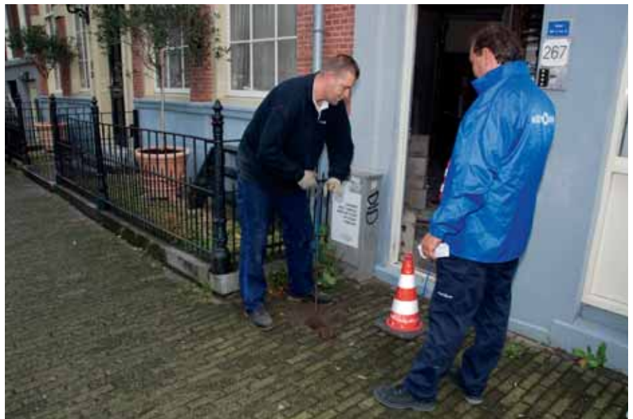
Watertoevoer afsluiten op straat. Michel van Meeteren (l.) en Marcel Schillemans (r.).
