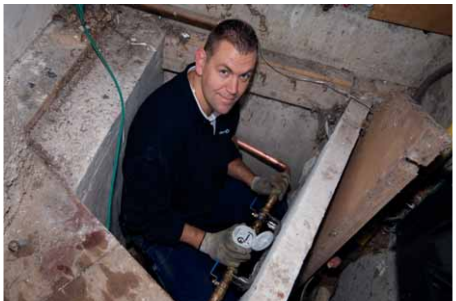
Watertoevoer afsluiten op straat. Michel van Meeteren (l.) en Marcel Schillemans (r.).
