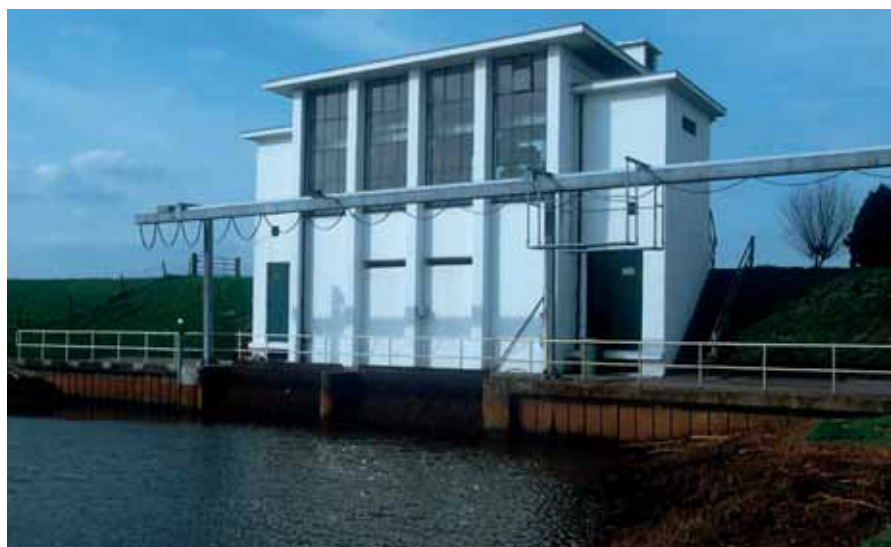
Gemaal Baakse Beek langs de IJsseldijk (foto: A. ter Harmse).
