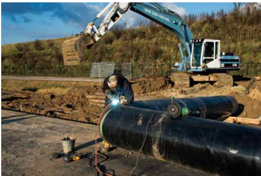
Frank Stevenaar, toezichthouder van Brabant Water, bij de watervoerende stalen buizen die langs de verbrede A2 worden geplaatst.
