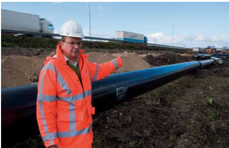
Frank Stevenaar, toezichthouder van Brabant Water, bij de watervoerende stalen buizen die langs de verbrede A2 worden geplaatst.
