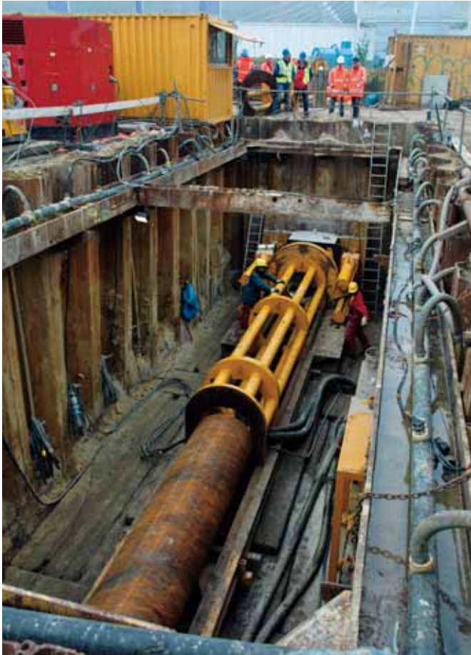
Een stalen mantelbuis wordt via een boring onder de A2 doorgevoerd (foto: Brabant Water).
