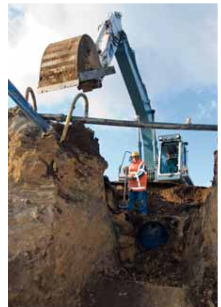
Grondwerker Toon Govers maakt de waterleidingbuis vrij om een aansluiting te kunnen maken.
