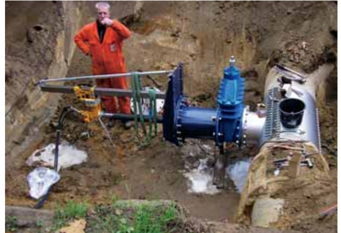
Aanboring bestaande waterleiding die onder druk staat (foto: Brabant Water).
