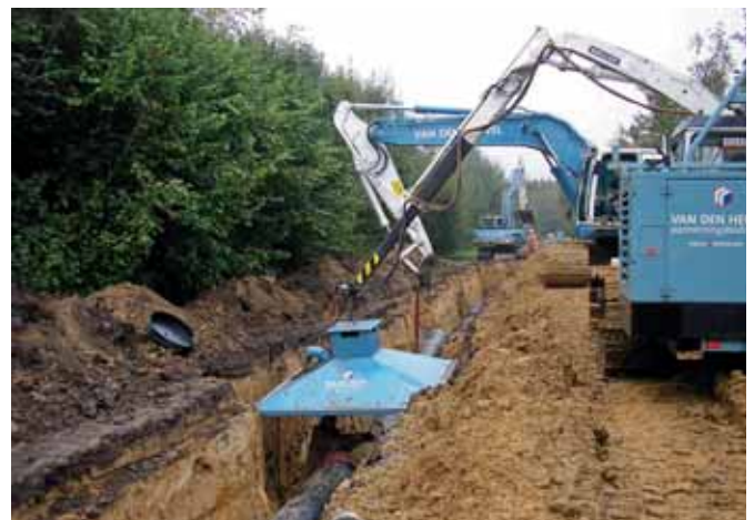
Onder beschermkap kunnen lassers van de stalen buizen hun apparaat aansluiten (foto: Brabant Water).
