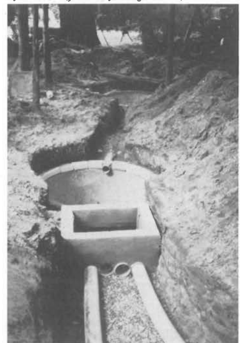
Afb. 4 – Aantag van de infiltratiegeulen te Epse.
