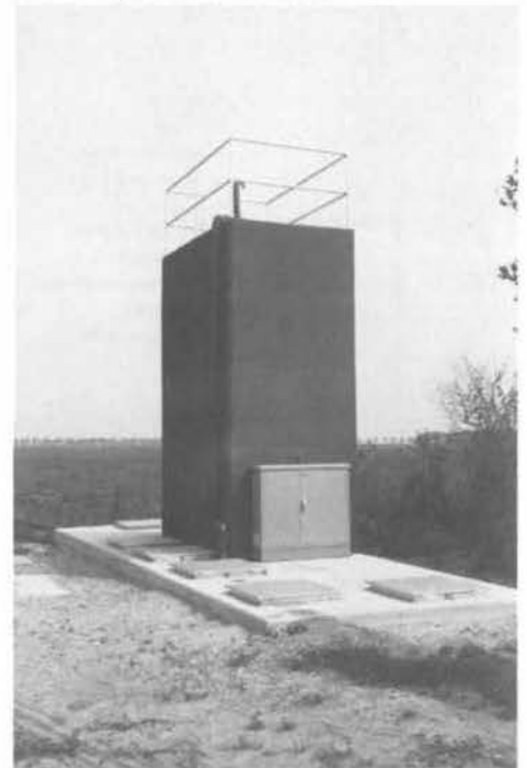
Afb. 8 - Oxydatiebed te Swifterbant.
