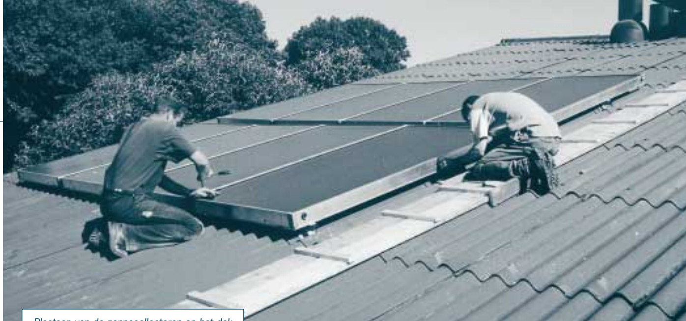
Plaatsen van de zonnecollectoren op het dak
