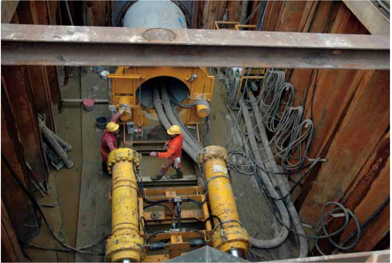
De aanleg van een dubbele waterleiding onder de A2 bij Maastricht (foto: Anjo Petit).
