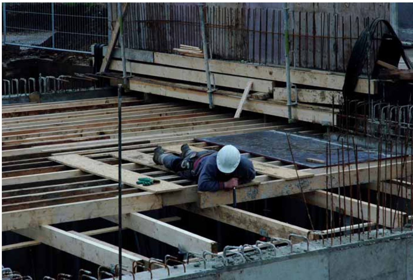
Renovatie van een installatie in Maastricht (foto: Anjo Petit).
