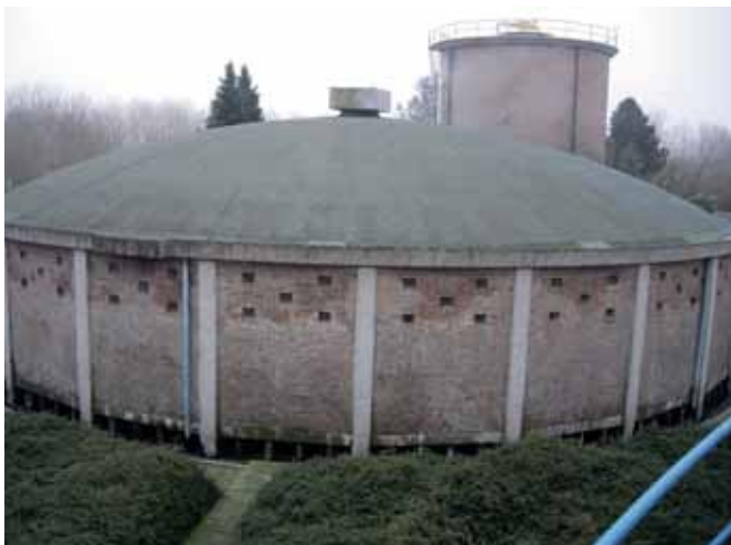
Oxidatiebed en beluchtingscircuit rwzi Vriezenveen.
