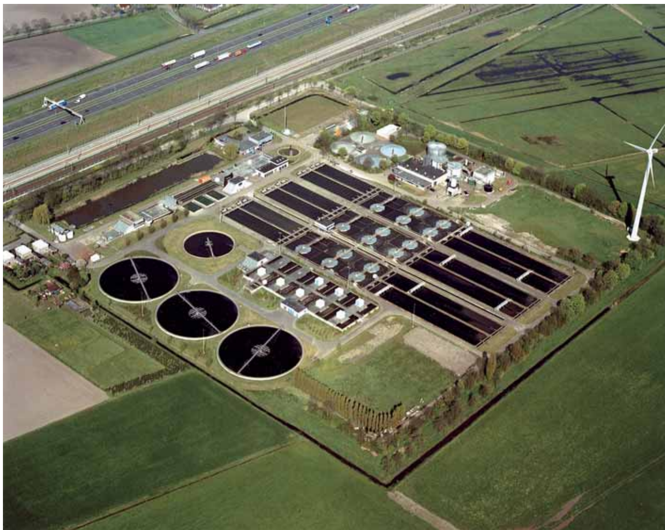
De rioolwaterzuiveringsinstallatie Nieuwveer in Breda.
