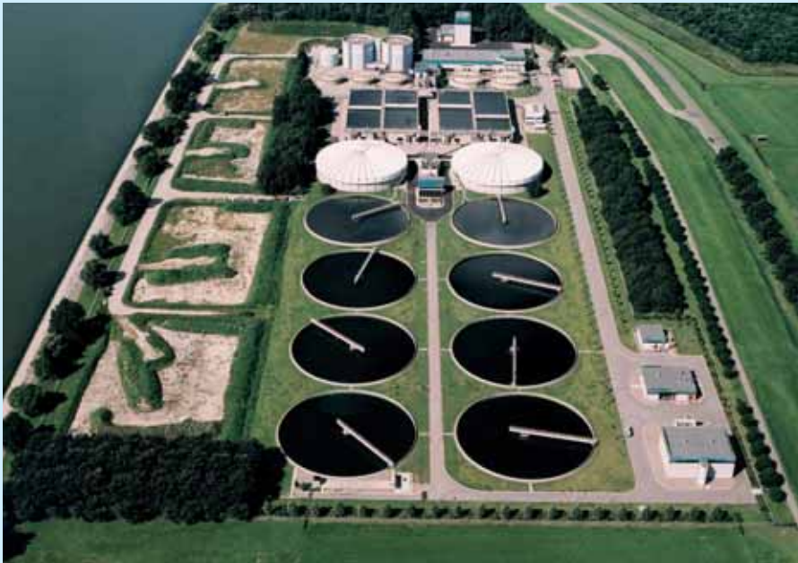
De afvalwaterzuiveringsinstallatie De Grootte Lucht te Vlaardingen.
