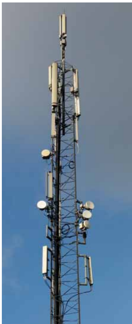
Mast met antennes van mobiele telefoniebedrijven. De ronde antennes zijn die van microgolfstraalverbindingen.
