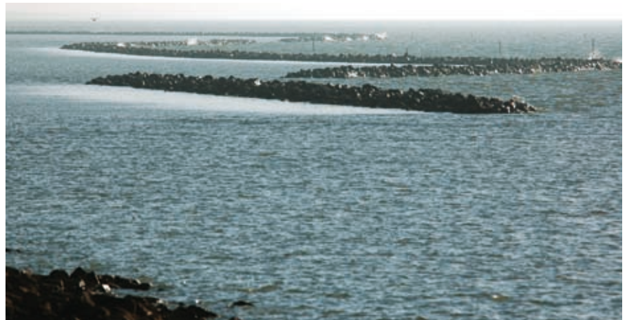
De Houtribdammen, zogeheten luwtedammen in het Markermeer (foto's: J. van Schie, Rijkswaterstaat).
