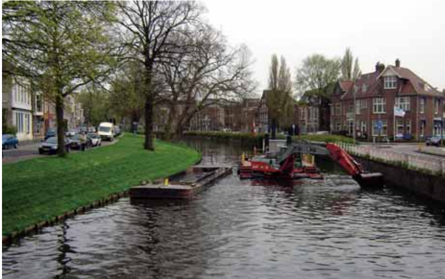
Baggerwerkzaamheden in Haarlem.
