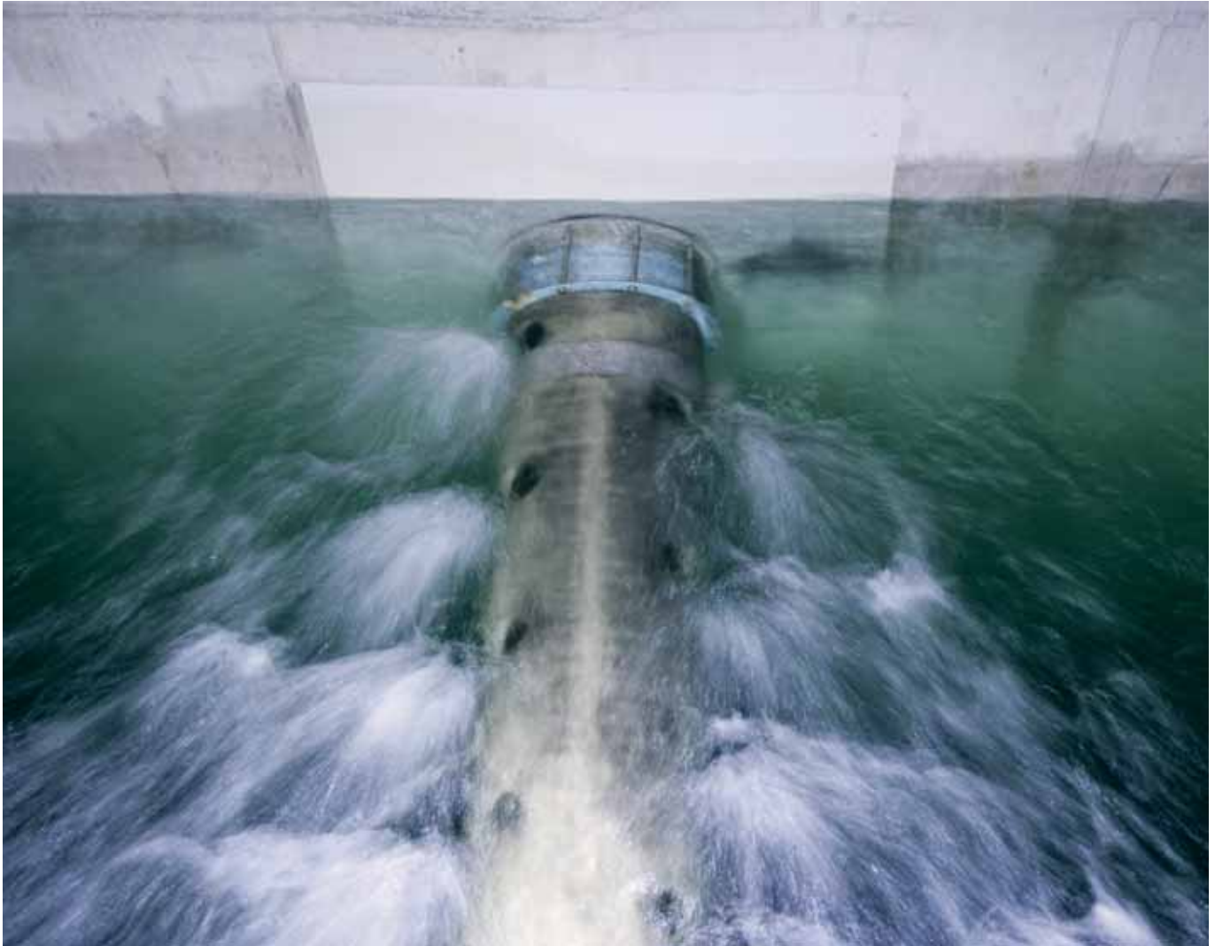
Bovenaanzicht van de actieve koolreactor.
