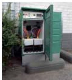
De Efccon Sampler met het automatische zelfreinigende verdeelsysteem.
