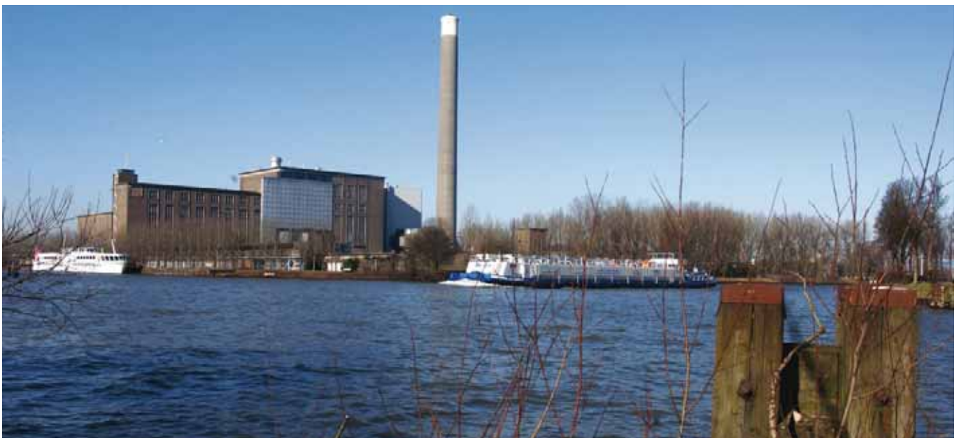
De elektriciteitscentrale Lage Weide bij Utrecht.
