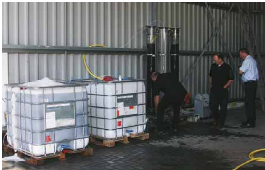
V.l.n.r. Bert Willemse, Bart-Jan Kordes en Nico Wortel (Grontmij) bij het bedrijfsklaar maken van de installatie.
