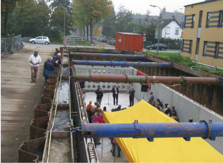
De bouw van een bergbezinkbassin.
