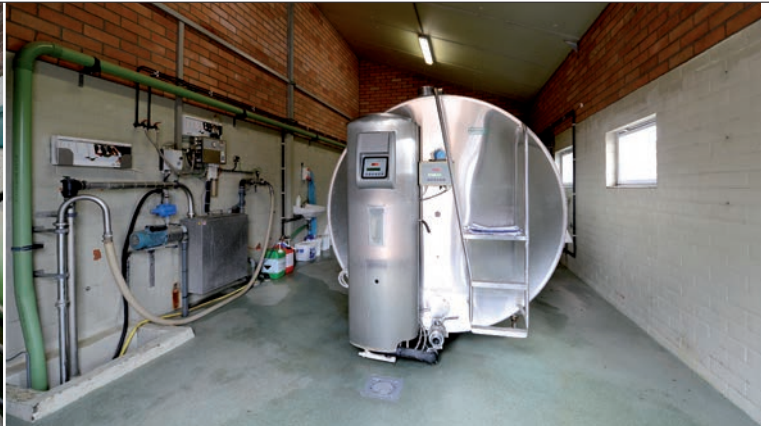
Ook het tanklokaal is schoon en opgeruimd
