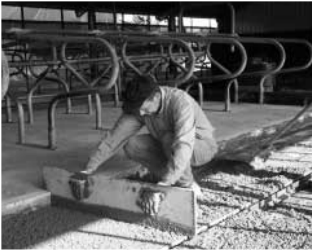
Het beton wordt eerst geëgaliseerd...
