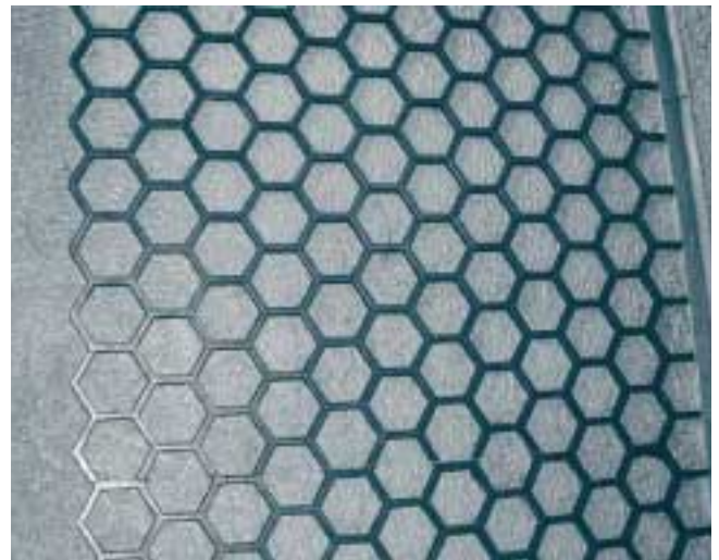
... daarna worden de matten op het beton gelegd...
