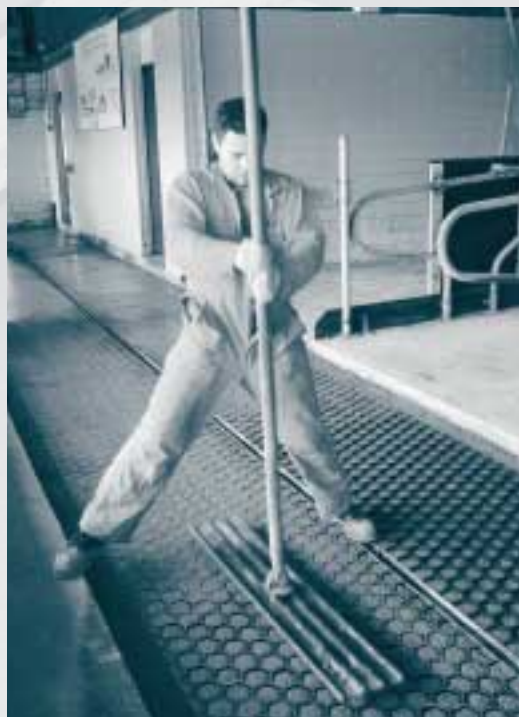
... en worden in het beton gedrukt
